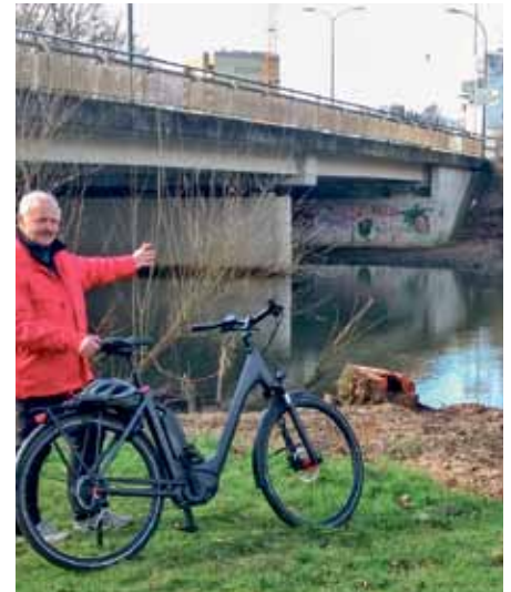
Eine neue Brücke für Radfahrer über die Fulda entsteht parallel zur Bardostaße.
